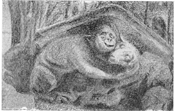
AVIGNON. — Palais des Papes, détail d'architecture.
