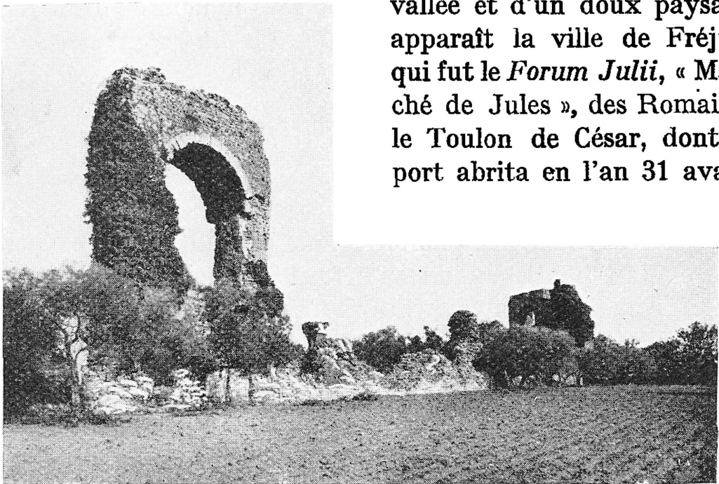
FRÉJUS. — Ruines de l'aqueduc romain.
