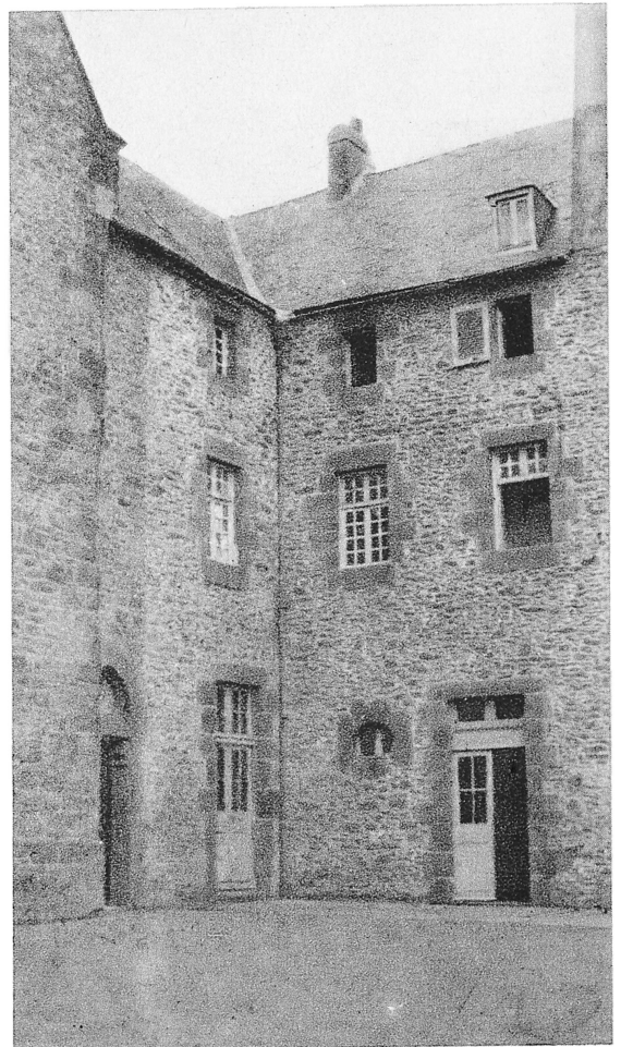
Vestiges de la Maison de la Croix.
